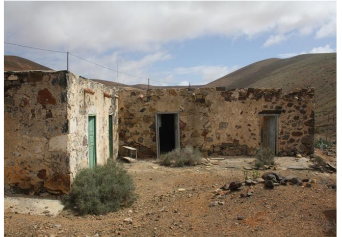
Fachada con huecos regulares.
