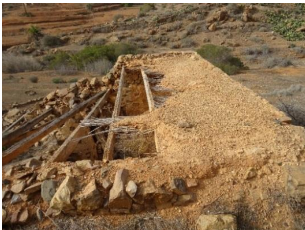
Sistema constructivo con vigas, tilla y torta.
