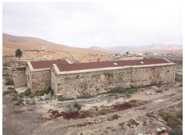
Acabado de cubierta con torta.
