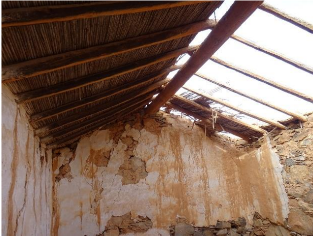
Sistema constructivo con vigas, tilla y torta
