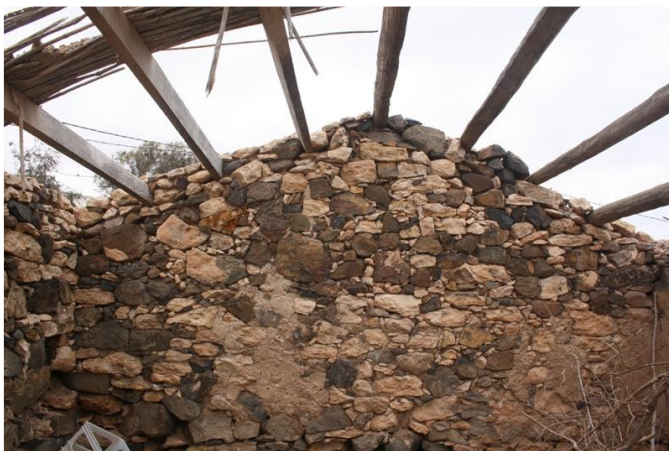
Muro de mampostería con caliches, basalto, gabro y ripio.
