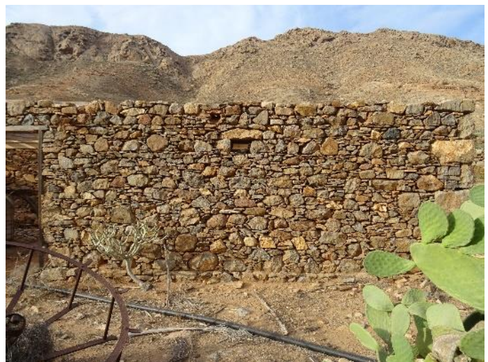
Ventana tronera orientada al norte.
