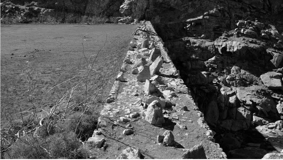
Muro de contención de La presa de Las Peñitas
