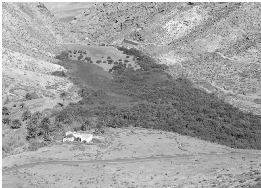
Foto 3. Presa de Las Peñitas.
