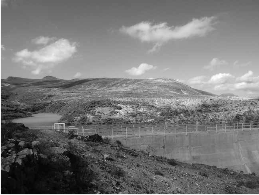
Imagen 3.6. Presa de Mala. Elaboración propia.
