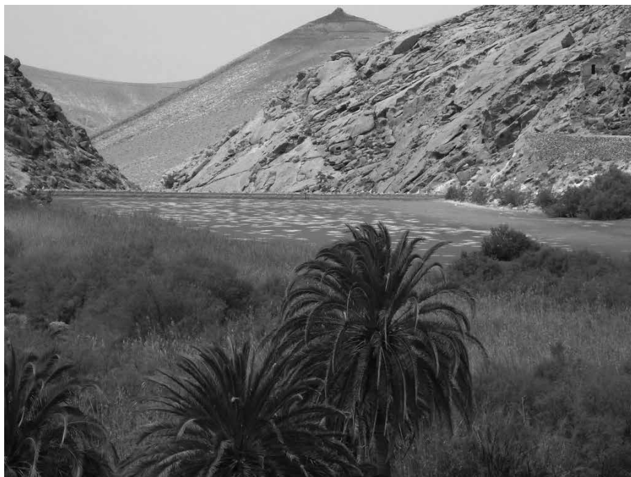
Foto 12. Presa de Las Peñitas.
