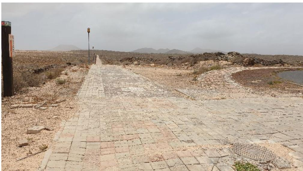
El trazado del acondicionamiento respeta la traza de la acera actual. Dispone de una sección de 5,40 metros con una plataforma adicional para la ubicación del báculo de alumbrado y otra para los bancos y papeleras y así permitir la acera para el libre tránsito de peatones y bicicletas, sin obstáculos.
