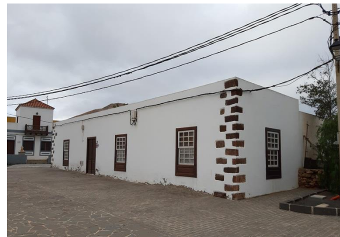
AR-131. Vivienda tradicional del TIPO 11.1 en Casillas del Ángel
