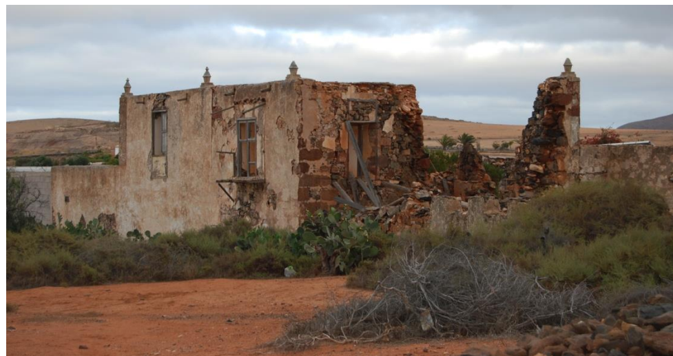
Casa rural en ruina. Casillas del Ángel
