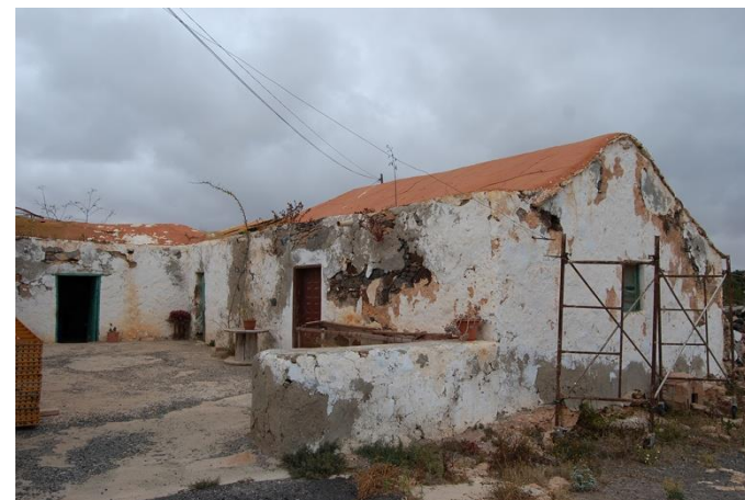
AR-238. Vivienda tradicional del TIPO 4.1 en Casillas del Ángel
