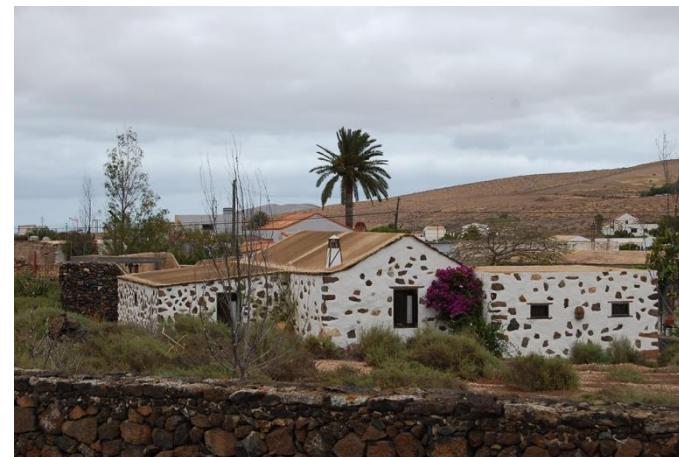
AR-240. Vivienda tradicional del TIPO 6, en Casillas del Ángel
