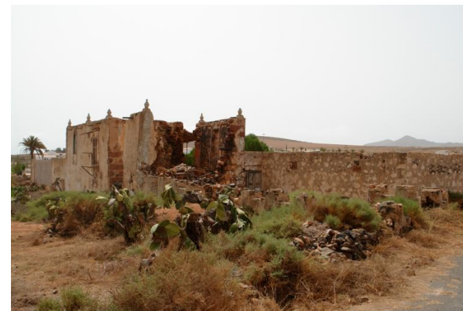
AR-216: Vivienda tradicional del TIPO 1.3 en Casillas del Ángel
