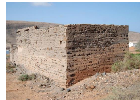
Construcción de “pared de cajón” en Guisgüey
