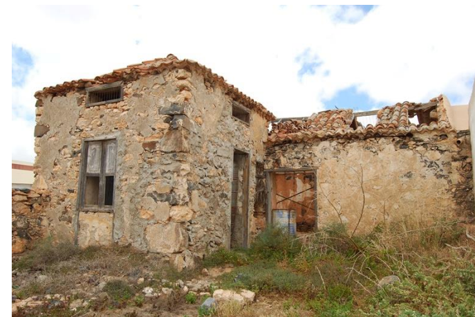
AR-167. Vivienda tradicional del TIPO 4.2 en Casillas del Ángel
